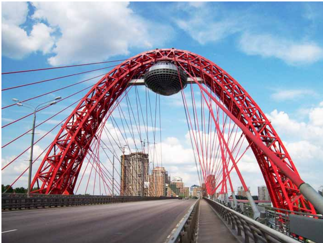
Вантовый мост «Живописный» через Москву-реку спроектирован НПО «Мостовик» при помощи SolidWorks.
